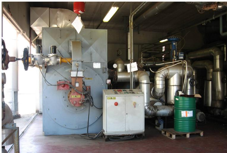
Centrale a vapore – con caldaia a gas naturale ed evaporatore ad olio diatermico.
