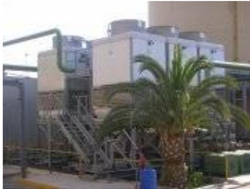
Impianto composto da n°6 torri evaporative complete di vasca e di struttura alettata, al servizio di impianto di produzione biodiesel.
