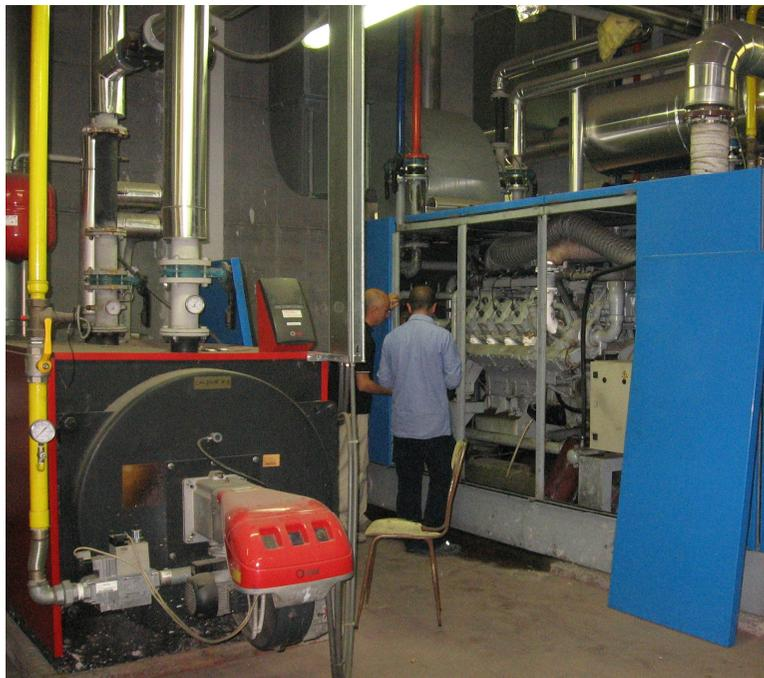
Centrale ad acqua calda tipo ibrida – con caldaia ed impianto cogeneratore, entrambi alimentati a gas naturale.
